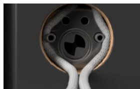
Figur 9 - Føring av ledninger
